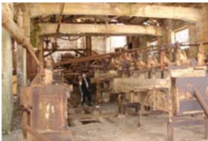
Abb. 12.b.3: Iglesias, Sardinien, Innenansicht (Außenansicht s. Abb. 5.5.3.q), Foto www.weiteferne2.de/sard08
