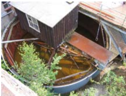
Abb. 5.2.i: Eindicker am Schrägaufzug, Foto 2010
