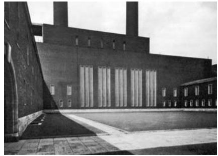
Abbildung 8.3.e: Kraftwerk Horst, Ent- wurf Schupp /BUS 1980/
