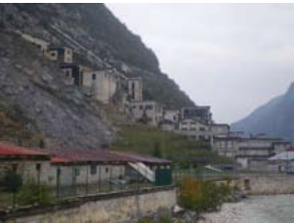
Abb. 5.5.3.r: Aufbereitung Raibl, Foto 2012
