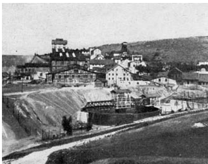
Abb. 5.5.3.a: Zentralaufbereitung Hilfe Gottes in Bad Grund, Foto 1924 /KRA 1948/
