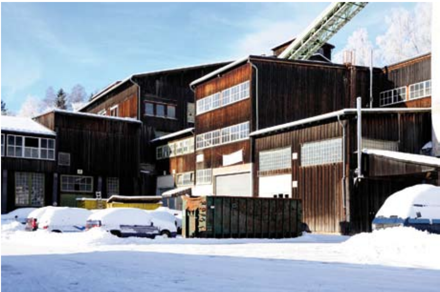
Abb. 8.1.b: Aufbereitungsanlage Grund, Foto von Raymond Faure
