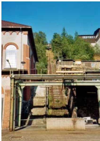
Abb. 9.1.b: Schrägaufzug Rammelberg, Foto U. Kammer 2008
