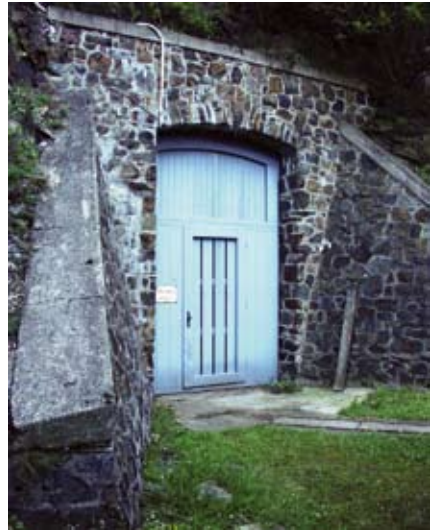
Abb.9.12a: Unteres Stollenmundloch vom Umspannwerk 2, Foto 2005
