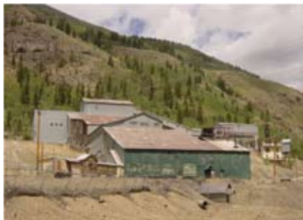
Abb. 12.h:Erzaufbereitungsanlagen Shennandoah-Dives Mill/USA, Foto aus wikimedia.org
