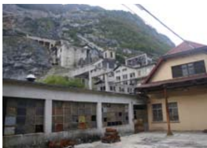
Abb. 12.b.11: Raibl, Südtirol, Außenansicht, Foto 2012
