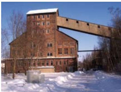
Abb. 12.a: Flotationsanlage Beihilfe Halsbrücke, Foto Volkmar Scholz
