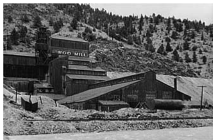
Abb. 12.f: Erzaufbereitungsanlagen Argo/USA um 1950, Foto aus www.route40.net
