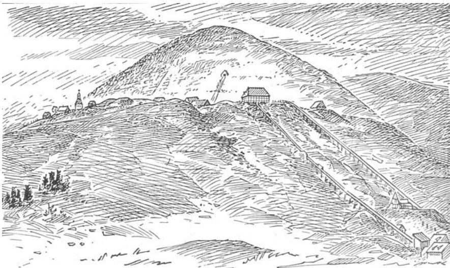
Abb. 5.4.c: Brandstaubschuppen (großes Gebäude in Bildmitte), Schienenbahn und Brandstaubwäsche (Gebäude rechts unten), nach Melchior Kraus, 1784
