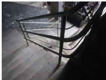
Abb. 11.2.a: Geländerdetail im Treppenhaus zwischen Mittelzerkleinerungs- und Mühlengebäude, Foto 2012
