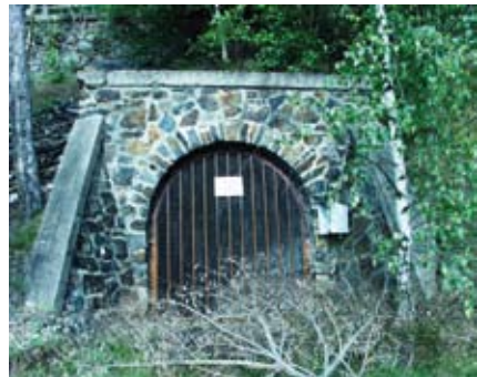
Abb.9.12.b: Oberes Stollenmundloch vom Umspannwerk 2, Foto 2005
