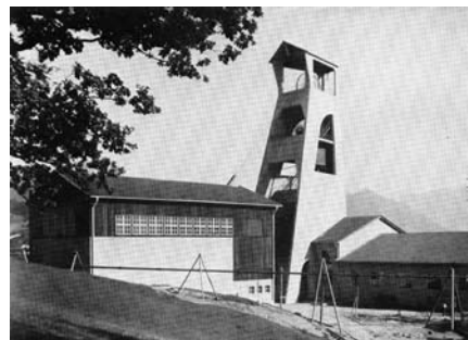
Abbildung 8.3.h: Haushamm, Detail der Bergwerksanlage von F. Schupp / BUS 2002a/
