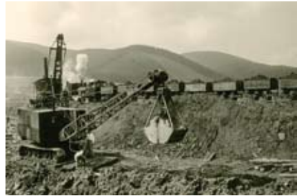
Abb. 7.e: Dammbau mit Bagger, Dampflok und Loren, Foto aus der Sammlung Stefan Dützer
